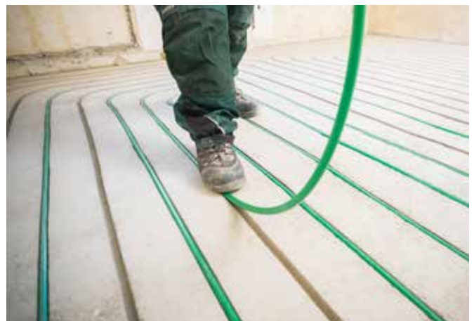
Verlegung der KLIMAPEX® Heizrohre in die gefrästen Kanäle.
