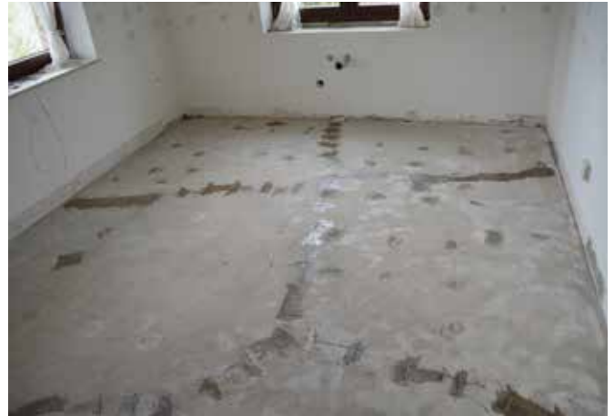
Bereitstellung einer ebenen, sauberen und trockenen Oberfläche.
