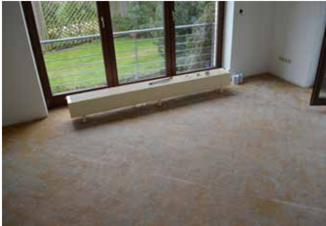
Entfernung der vorhandenen Oberbeläge und Heizkörper.
