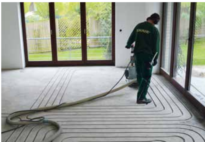
Nahezu staubfreie Kanalfräsung in den bestehenden Estrich durch erfahrenes Montageteam gemäß Verlegeplanung.
