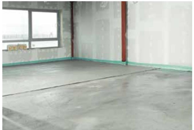
Einbringen eines Ausgleichsestrich im System PURFLEX®-super, Dicke  $\geq 20$  mm.
