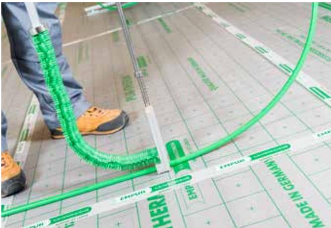
Einbringen des Flächenheizungssystems wie z.B. PUR-THERM® Tacksystem, alternativ Exclusiv-Klett-System oder Clipp-schienen.
