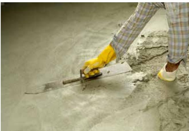
PURFLEX®-super B02 Verlegemörtel mit der Kelle aufziehen, mit Glättkelle die Stege auffüllen, Fläche glätten und 24 Stunden ruhen lassen.
