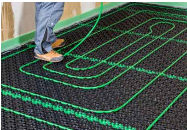
Das Heizrohr wird durch leichten Druck mit dem Fuß in die Noppenstruktur eingeklickt. Die optimierten Rohrhaltenoppen fixieren das Heizrohr sicher in der Platte.
