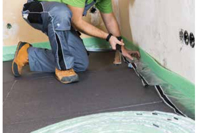
Anbringen des Randdämmstreifens an allen aufgehenden Bauteilen. Eine zuverlässige Abdichtung muss gewährleistet sein.
