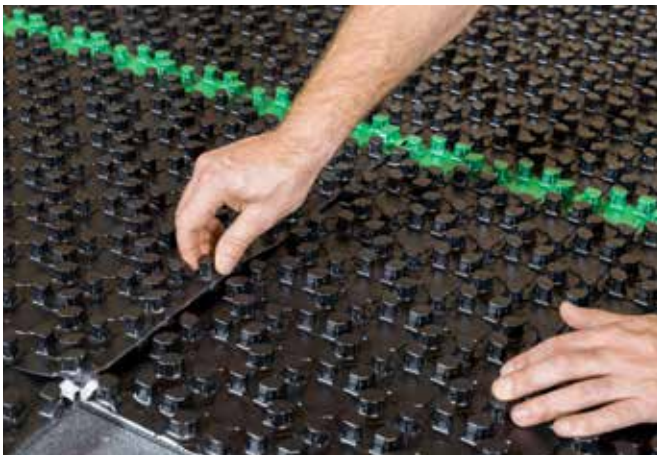
Beim Auslegen der Noppenplatten werden die Elemente durch die einreihigen Stülp- und Aufnahmenoppen materialsparend im Druckknopfverfahren miteinander verbunden.
